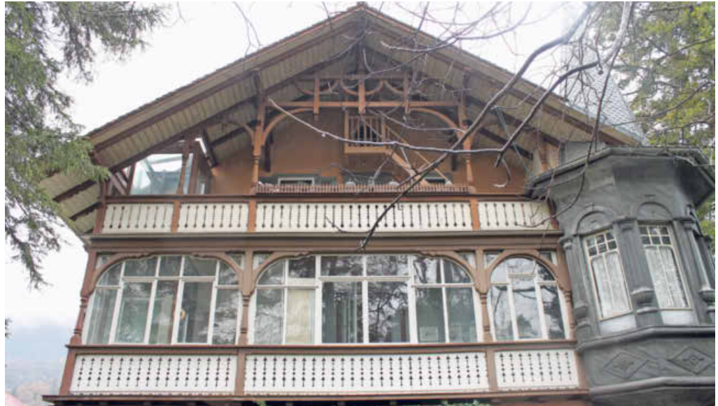
Villa Mon Abri: mit Türmchen und alten Glasfenstern verzierte Vorderansicht.
